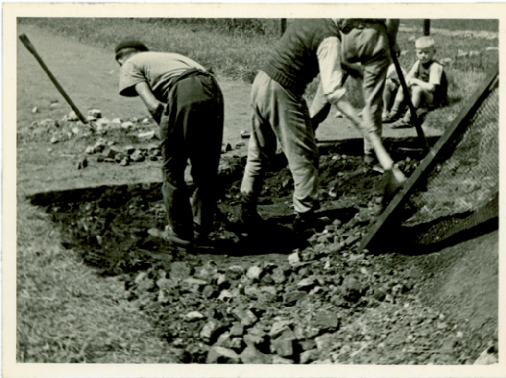
Opgraving van heldenhuldezerkjes, Adinkerke, augustus 1942. [ADV.N. VFFY19/14]
