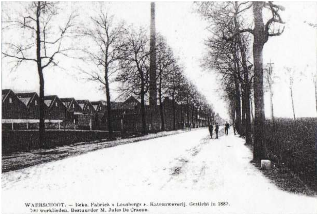
Figuur 3: foto van de weverij van de S.A. Lousbergs, genomen vanop de weg Gent-Eeklo. De grote hal met het typische dak en het machinegebouw met schoorsteen zijn duidelijk te zien.
