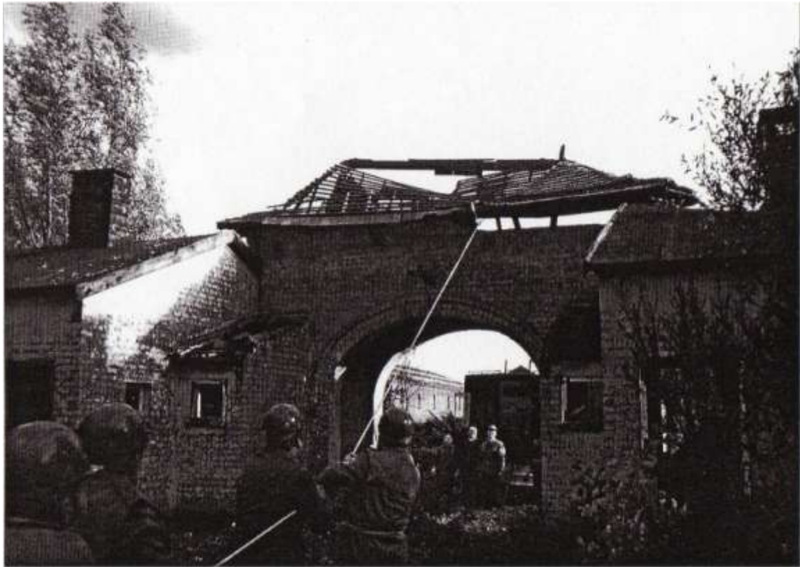
figuur 9: de sloop van de poort van de woonwijk S.A.W. in 1992
