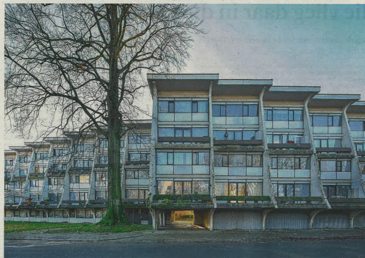
Braem ontwierp een gebouw op pilotis , maar de doorzichten raakten ingevuld met garages en bergingen. © Bart Gosselin
