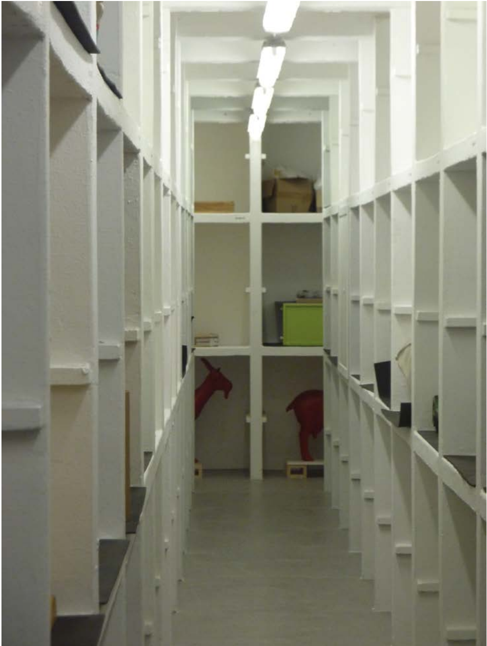
Depot na herinrichting, zicht op originele herbruikte magazijnstructuur van het warenhuis. (ontwerp Gaston Eysseleinck). © Inge Bertels
